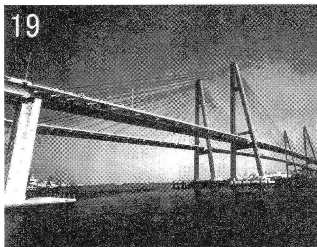
図2 No.19 名港西大橋
