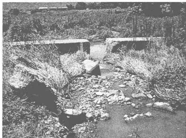
写真-2 スリットに繋がる水みち（侵食流路）
