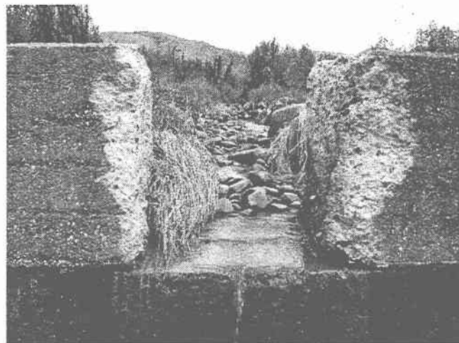
写真-1 スリット近景（下流より上流を見る）
