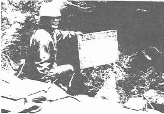
▲露岩上に設置した土石流検知センサー（南大王川）
