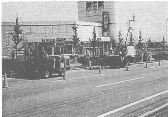
写真2 現地作業状況
