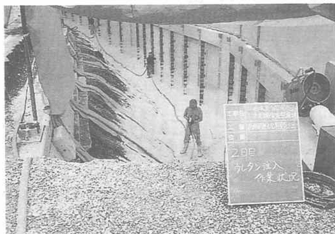
写真-1 現場発泡作業状況
