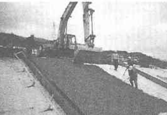
写真-1 転圧状況
