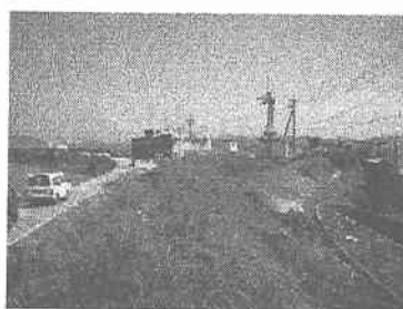
写真-1 霞堤・水越堤
