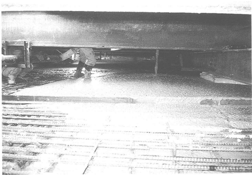
写真-1 NVコンクリート打設状況
