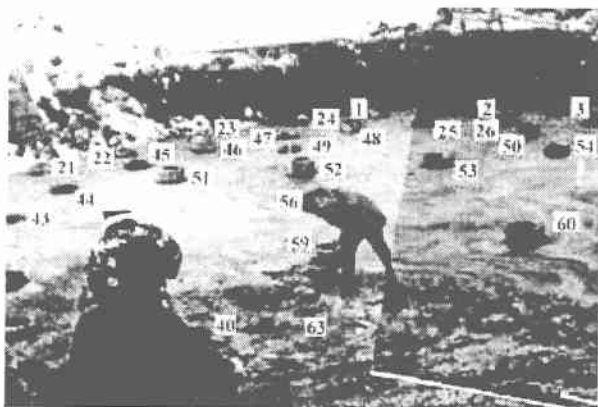
写真-1 杭打設に続く捨てコンクリートを打設し、表面をならしている最中の施工写真 (1969.12.)
