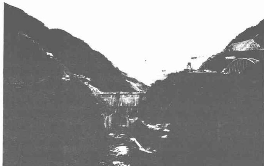
写真-1 ダム下流面全景
