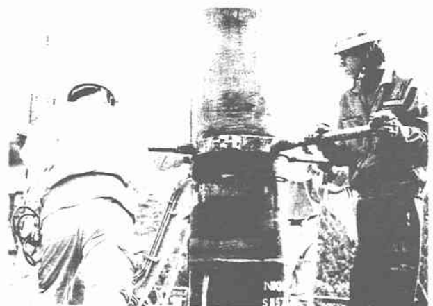
図-3 高張力及びネジ継手の施工状況
