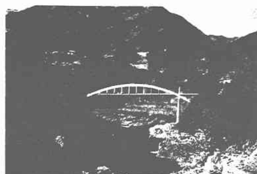
写真-1 大歩危橋
