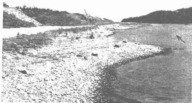
図 14 四万十川河口の水制工完成後 12 ヶ月の状態 15)
