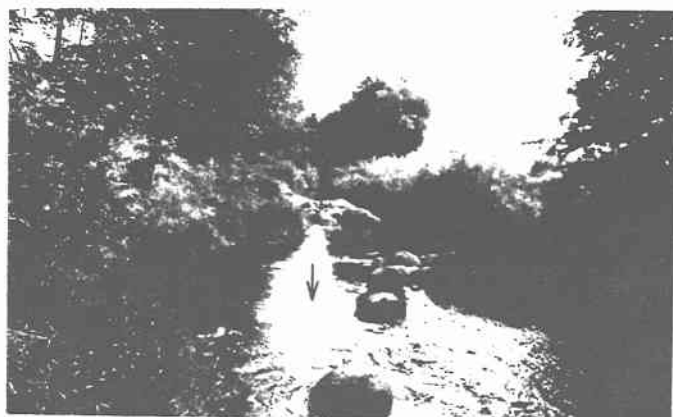
近自然河川工法による改修区間
