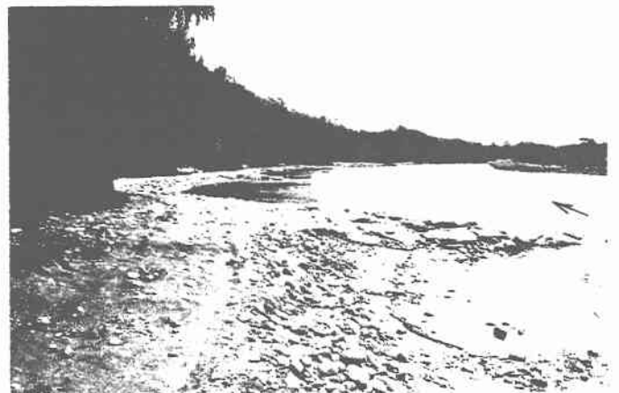
図3 愛知県・矢作川の水制工
