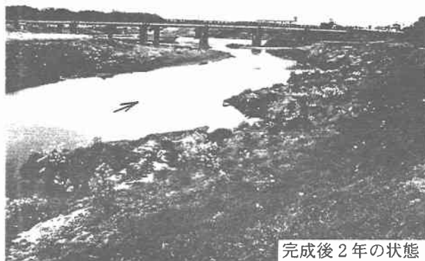
図4 宮崎県・大淀川の低水水制工
