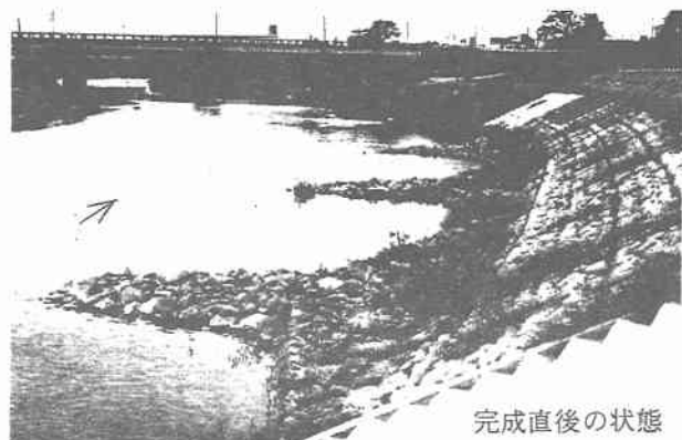
図4 宮崎県・大淀川の低水水制工
