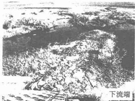
図5 鹿児島県・川内川の低水水制工（完成1年後の状態）
