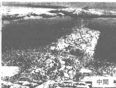
図5 鹿児島県・川内川の低水水制工（完成1年後の状態）
