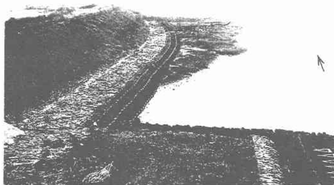
図 13 四万十川河口の水制工施工場所(施工前) 15)
