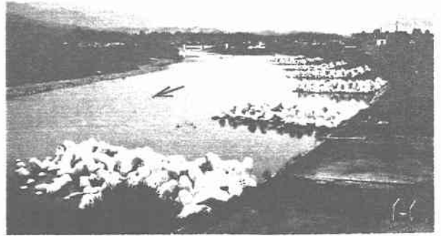
図9 熊本県・球磨川の根固めブロック水制工
