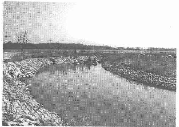
写真5 セセラギ水路（下流部）
