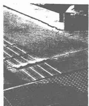
写真-4誘導ブロックの剥離
