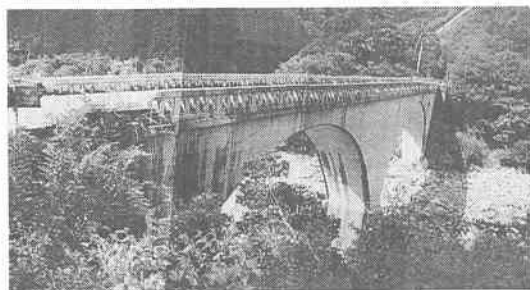
写真-1 二股橋の現況
