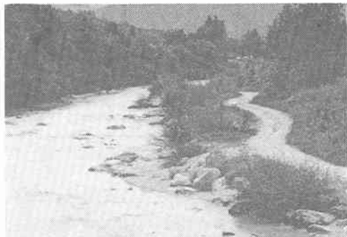
低水路法線は緩やかな蛇行をもたせ、水際は根固め水制で護岸基礎前面部の洗掘を防いでいる
