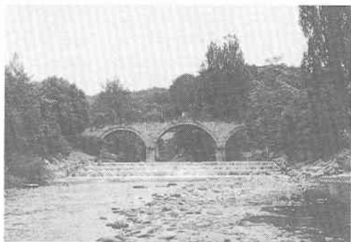
1806年につけられたローマ橋。重量車輛に耐えられず 近年つけかえられたが、元のデザインはそのままに
