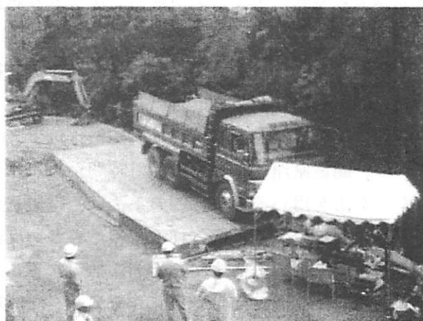
写真-2 荷重載荷実験状況（ダンプトラック）
