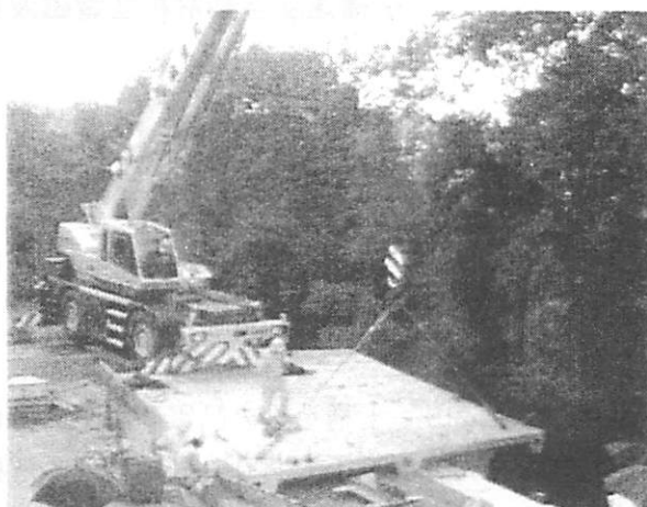
写真-1 施工実験状況
