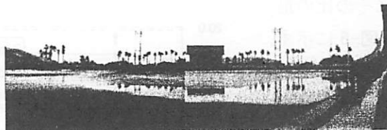
写真-1 降雨後のグラウンド状況 (降雨後1時間) 降雨時間約10時間 (降雨強度平均4mm/h max10mm/h)
