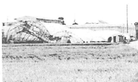
写真2 倒壊したビニールハウス
