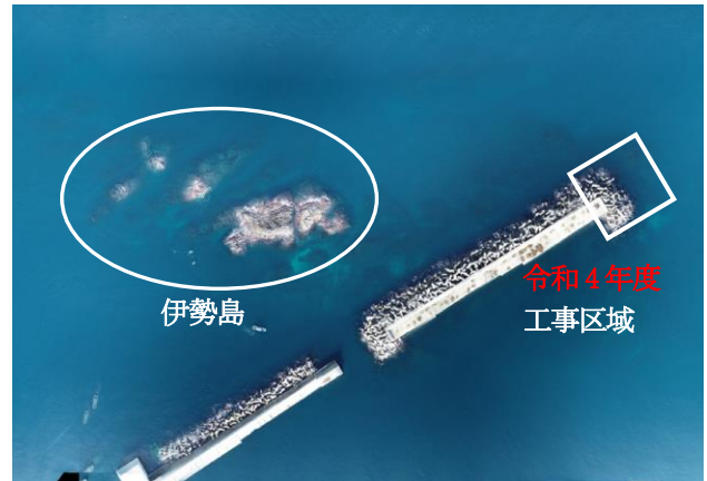
図-2 防波堤(新北)及び伊勢島周辺の状況 (令和2年12月28日撮影)
