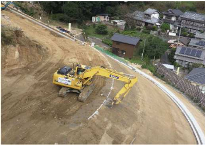
図1 MC 施工では精度確保が困難な曲線部の状
