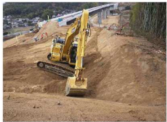
図4 重機を傾けて施工した事例
