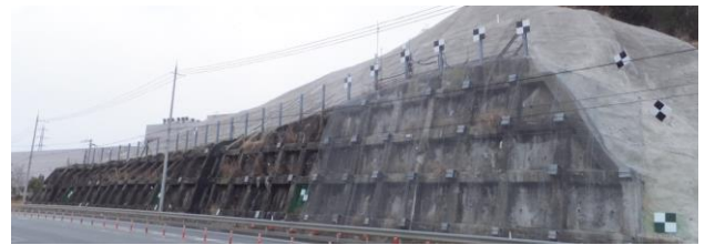
図-5 計測対象とした法枠付き法面
