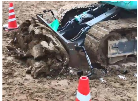
図4 切削後の土の堆積状況 (ケース3)
