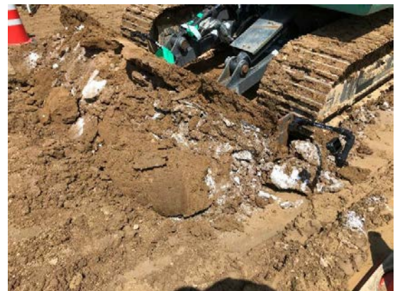
図6 切削後の土の堆積状況 (ケース4)
