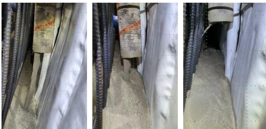
図-6 本システムでの打設状況
