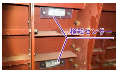
図-5 センサーと制御盤システム
