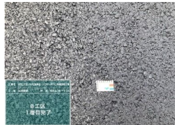
写真-3.2 B工区 写真-3 転圧後路面
