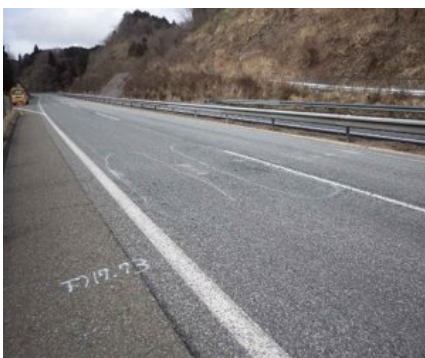
写真-1.1 路面状況
