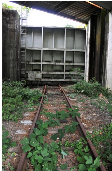
写真-4 廃線後に閉じられた浜原陸閘門
