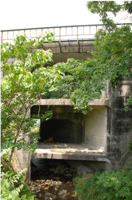
写真-2 目の字型ラーメン構造の日向川橋梁
