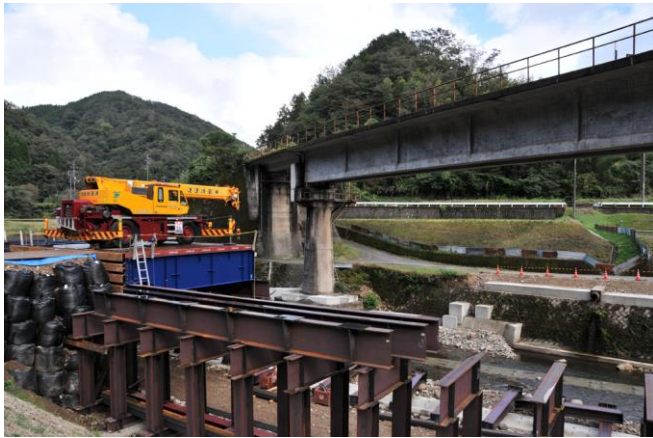
写真-9 撤去準備が進められている第1 沢谷川橋梁
