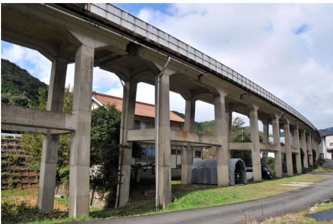
写真-7 ハの字型橋脚の都賀大橋高架橋
