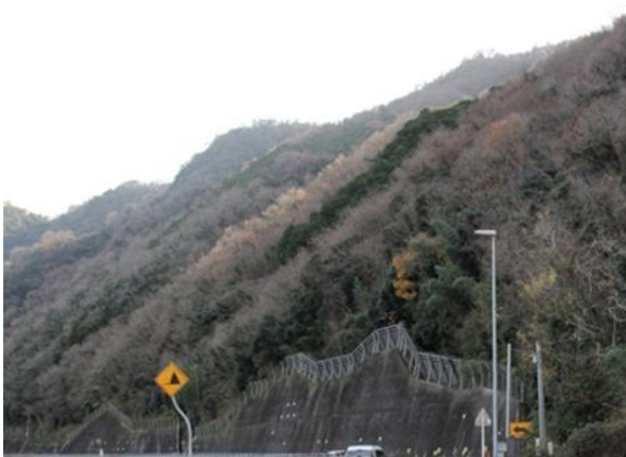
図-1 LP計測現地の状況
