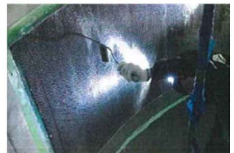
写真-1 繊維シート接着工 1)
