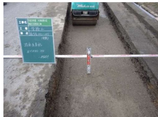
図-4 施工状況 (下水道管渠工事)
