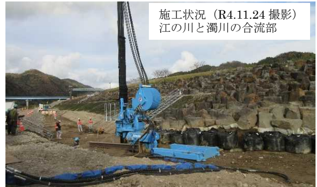
写真-1 矢板打設状況
