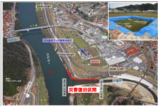
図-2 噴砂箇所と災害復旧区間
