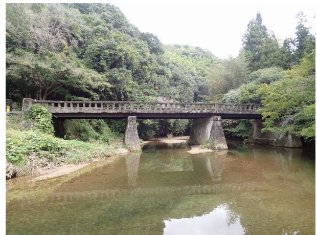
写真-1 束荷橋側面状況
