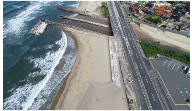
⑦前浜の復旧と道路の復旧 (対策完了)
