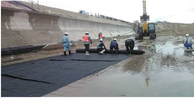
④サンドバックの施工
