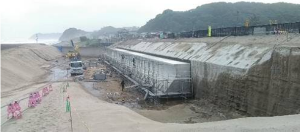
③サンドバック下の遮水シートの設置
