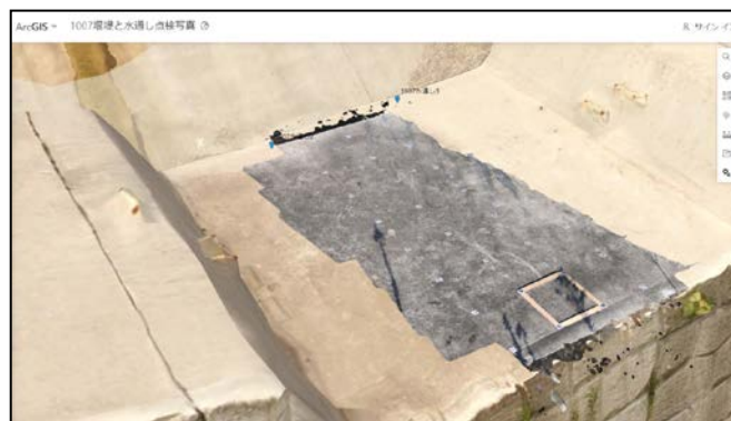
図 6 堰堤に貼り付けた点検写真
