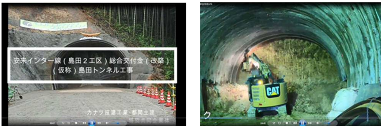
（一般県道安来インター線島田トンネル）
