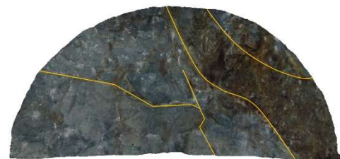
(b) 後の切羽の三次元モデル
