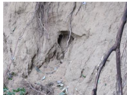
写真-1 崩壊斜面のパイピング跡(上安地区)
