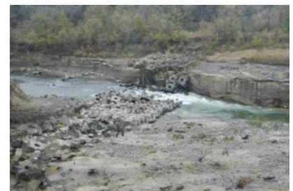
図-1 河床低下の状況 上: 無加川, 下: 然別川
