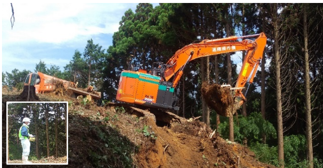
写真-6 無人化施工機械(遠隔操作)による頭部排土
