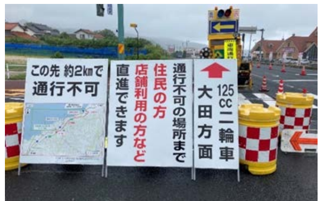
写真-9 看板設置状況
