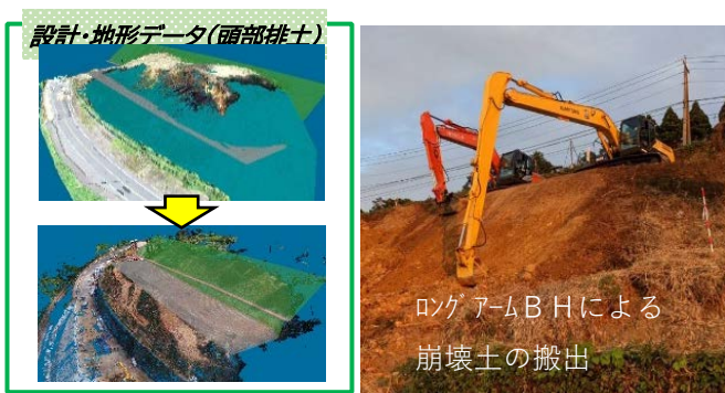
写真-7 CIMモデルを活用したICT建機施工
