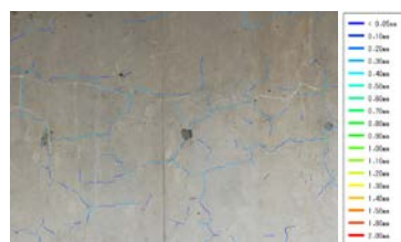
図-4. AIによるひび割れ検出結果
