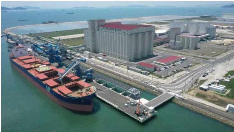
写真-1 岸壁完成後の供用状況(令和2年6月撮影)
