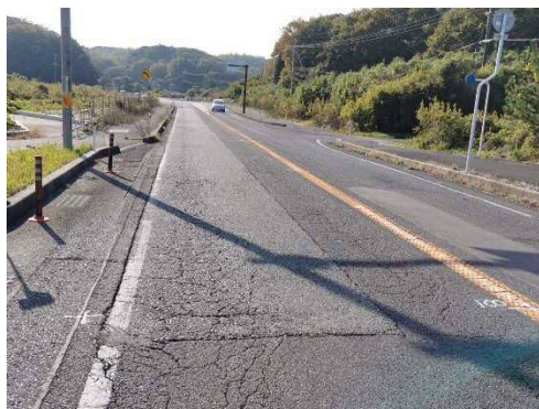
写真-2 大池2工区起点側
