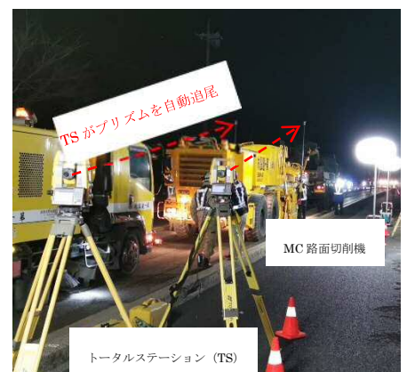
写真-1 MC路面切削機とTSの設置状況
