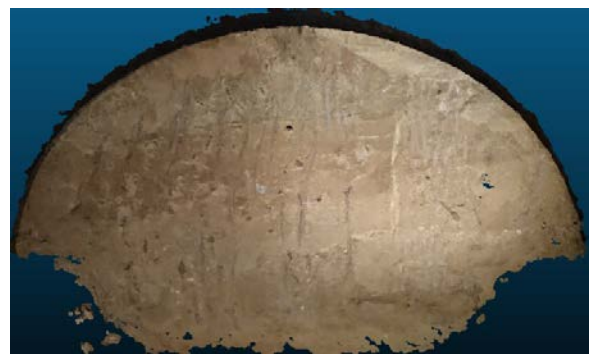
図-3 Metashape で構築した点群データ (A トンネル)
