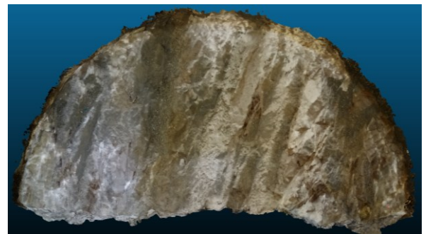
図-5 Metashape で構築した点群データ (B トンネル)
