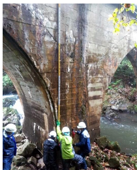
写真-1 現地計測の様子
