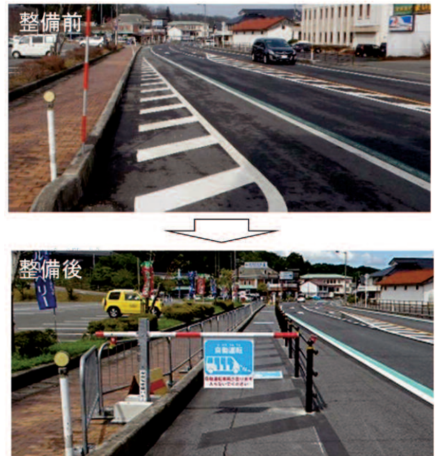
図5 専用空間の様子(上:整備前 下:整備後)
