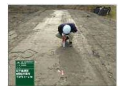
写真-6 表面沈下量測定
