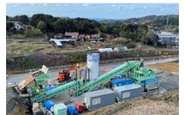
写真-7 回転式破碎混合機によるプラント設置状況
