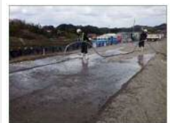
写真-5 散水の状況
