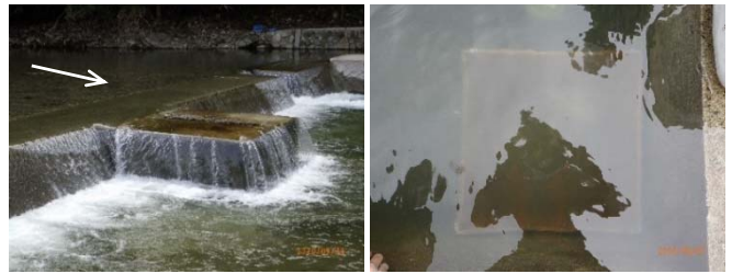
図-3 観測柵・装置設置の状況
