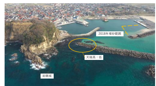
図2 久手港堆砂状況(2021年3月)
