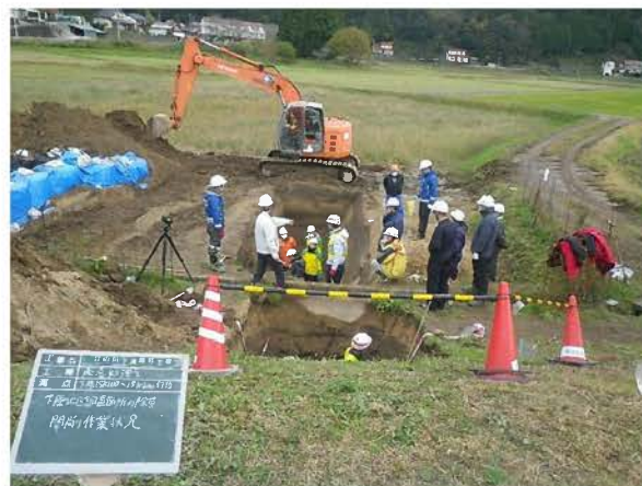
写真-4 開削調査
