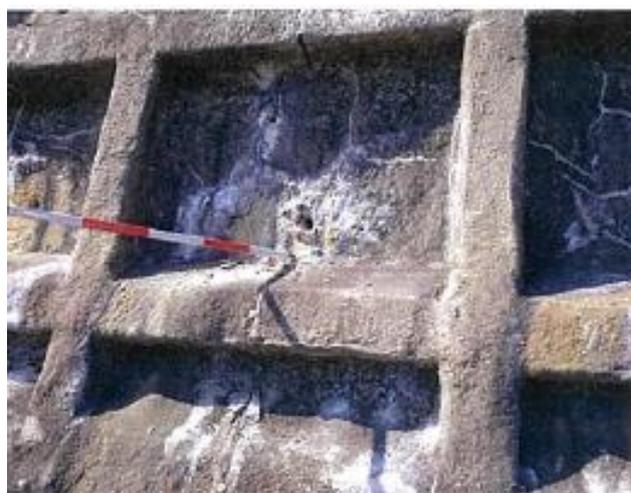
図-3 法枠内で観察される開口亀裂と剥落
