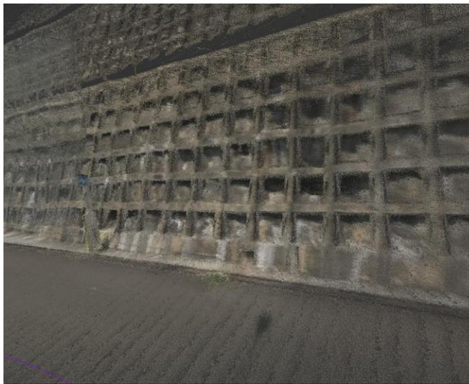
図-5 法面の3次元形状の復元結果
